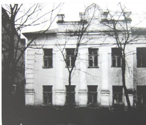
Напівзруйнована будівля синагоги
