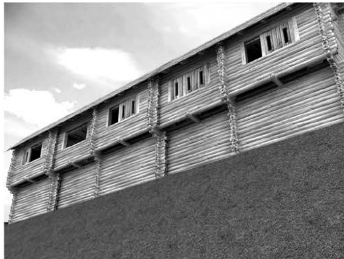
Рис. 6. Реконструкції двох'ярусного оборонного укріплення. Перший ярус – чотиристінна городня. Другий ярус (заборол): А – стоякова-балковий каркас; Б – зрубна конструкція. Верхня частина заборол складається з прямокутних дерев'яних щитів, що відкриваються всередину. У щитах виконані вертикальні прорізи-бійниці. Реконструкція В. Лук'яненка і В. Янченка. Малюнок О. Левченка.
