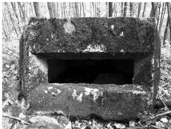
Фото 1. Залізобетонний ковпак з амбразурою зі скосом за вертикаллю (фотографія Максима Ющенко, м. Київ).
