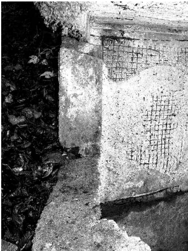
Фото 10. Пази для кріплення додаткових конструктивних елементів.
