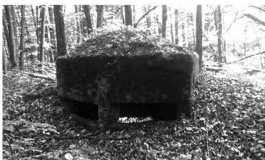
Фото 5. Двоамбразурний залізобетонний ковпак Уличського вузла оборони (фотографія Олексія Слободського, смт. Великий Березний).
